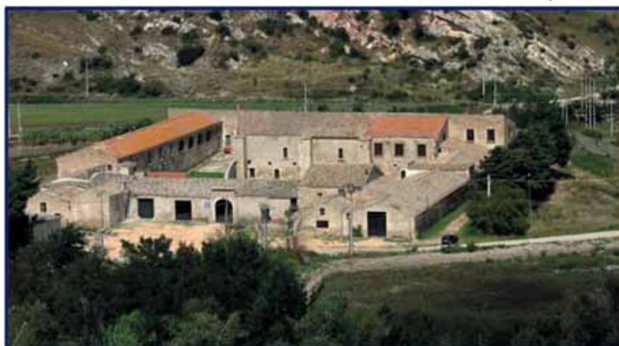
L'impresa si occupa, tra l'altro, del recupero di borghi storici. In foto il Comune di Bovino, in Puglia, Palazzo Fortini, Torre Enel, Torre a Termoli
